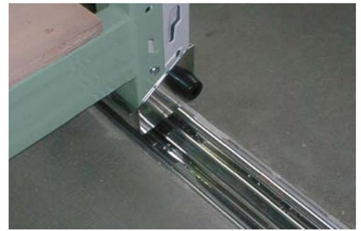
床面にレールを埋め込む用の溝を掘り、その中にレールを敷設し、再度コンクリートで埋め戻す方法です。
