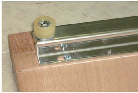
厚さ24mmの合板を敷き、その上にレールを敷設する方法です。床面にアンカーを打ち込めない場合や賃貸物件で床への直接工事が出来ない場合に用いる設置方法です。
